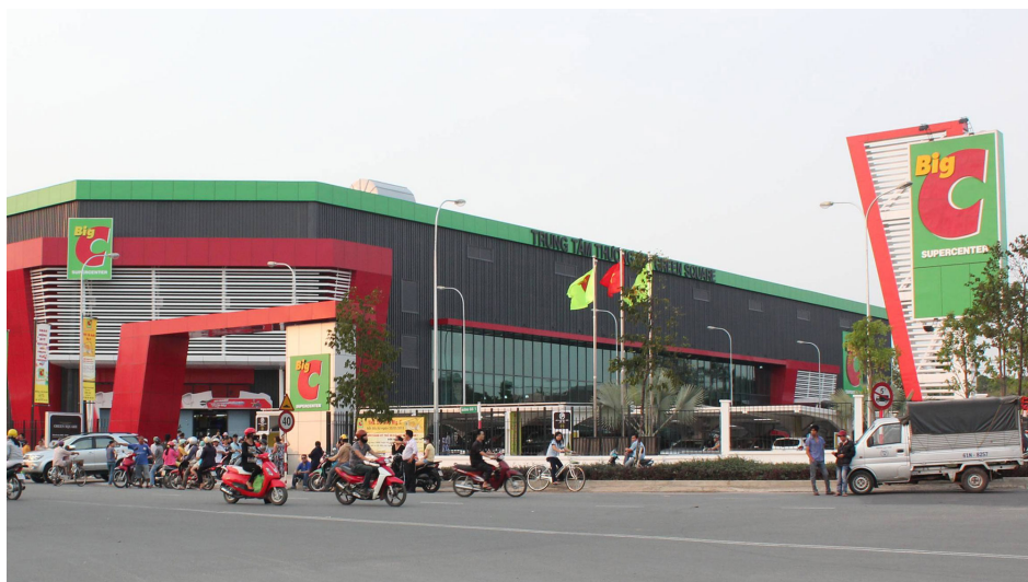
Hệ thống siêu thị BigC thuộc Central Group Thái Lan tại Việt Nam
